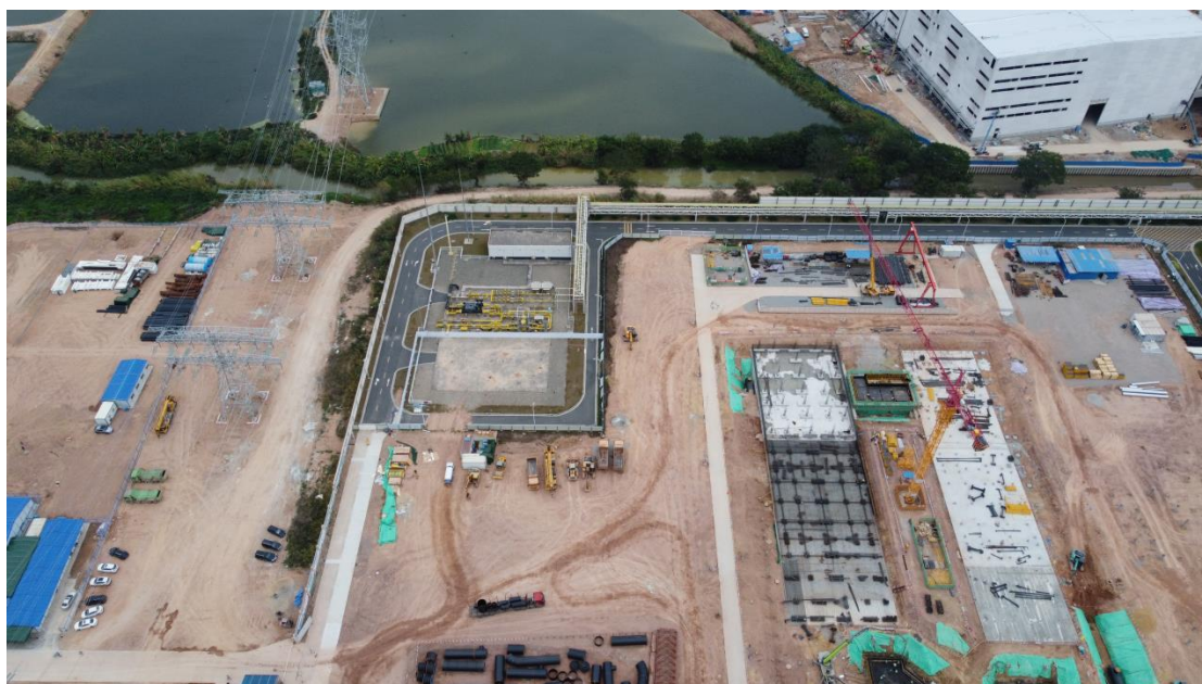
冷却塔区域施工
