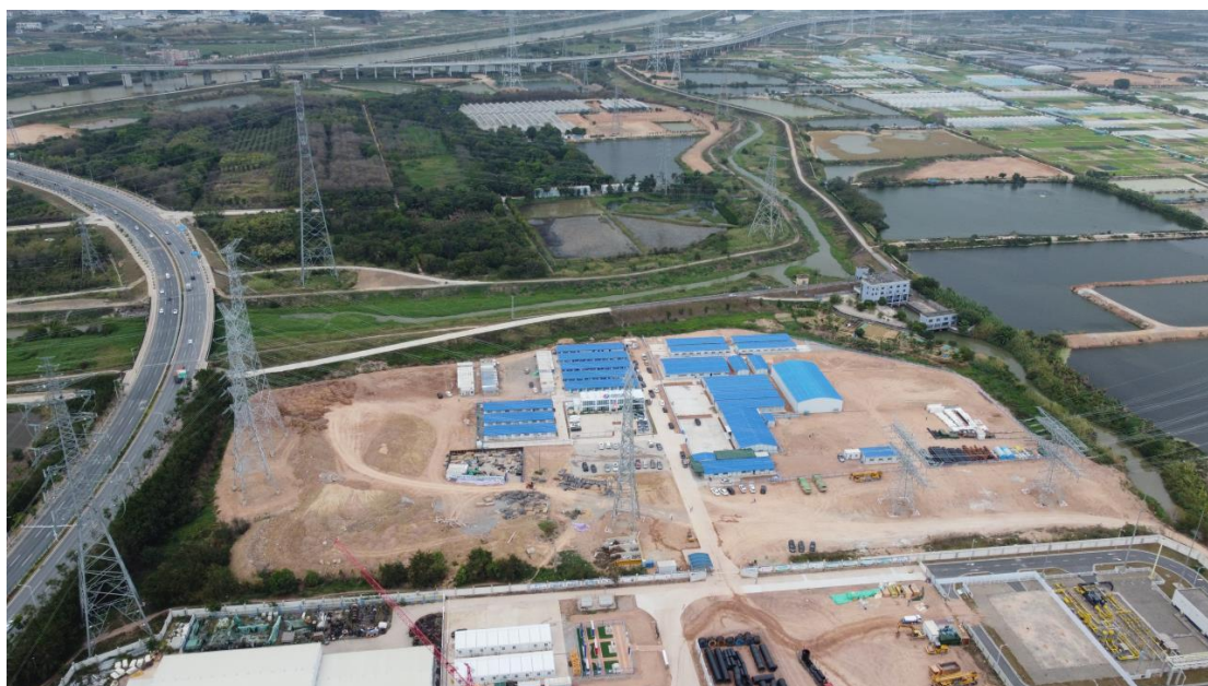
施工生产生活区现状
