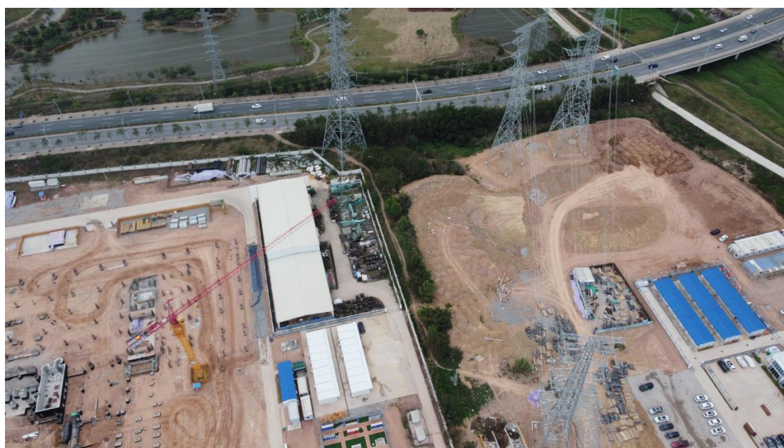
施工生产生活区西侧临时堆土
