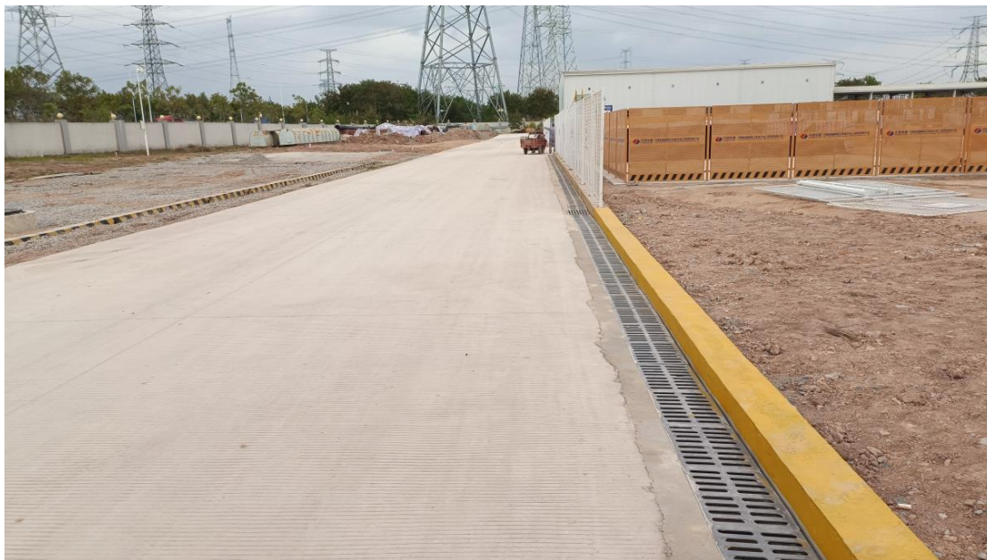
厂区道路排水沟
