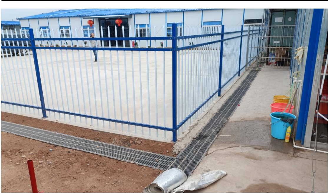
施工板房周边临时排水沟
